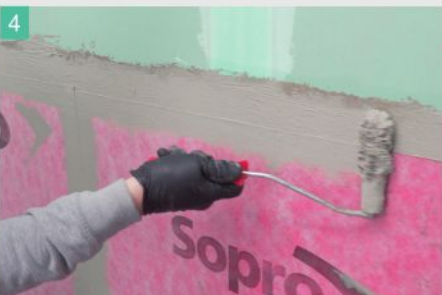
4 Bahnenabschlüsse mit FDK 415 überarbeiten
