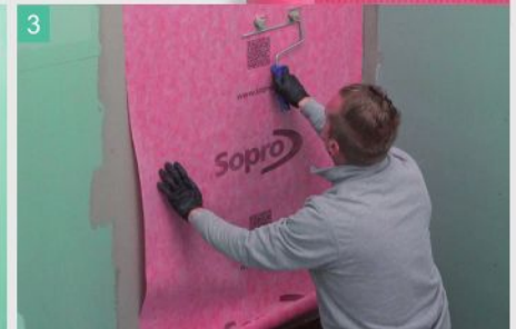
3 AEB® 640 in frische Schicht FDK 415 einlegen und andrücken
