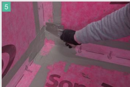
5 AEB® Dichtband Flex 148 in FDK 415 einlegen
