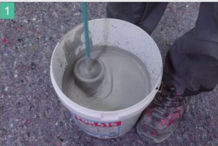
1 Saugende Untergründe grundieren und FDK 415 klumpenfrei anrühren
