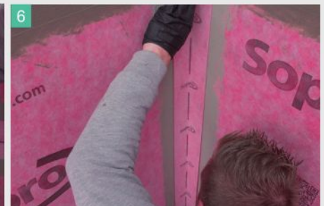
6 Sicheres Abdichten aller Ecken
