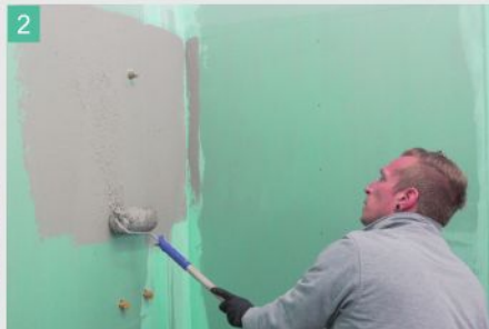
2 FDK 415 deckend im Kreuzgang auftragen
