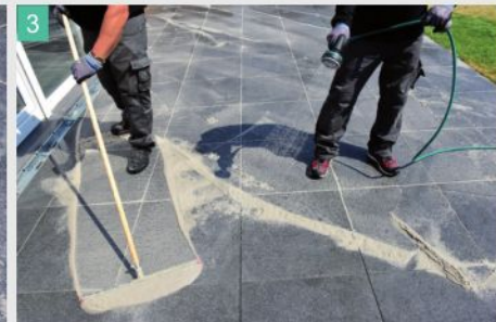
3 Die Fläche während des Fugens stets feucht halten
