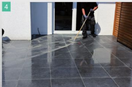
4 Überschüssigen Fugenmörtel abtragen
