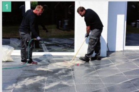
1 Material mit dem Wassersprühstrahl befeuchten
