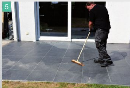
5 Mörtelreste gegebenenfalls abkehren
