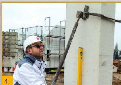
4. Das 1. SWE aufstellen und mit einer Strebe absichern
