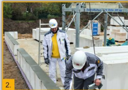
2. Mörtelausgleichsschicht/ Dünnbettmörtel aufbringen
