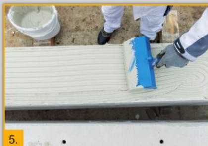
5. Am 2. SWE Dünnbettmörtel aufbringen, aufstellen und mit einer Strebe absichern, Justierplättchen einschlagen
