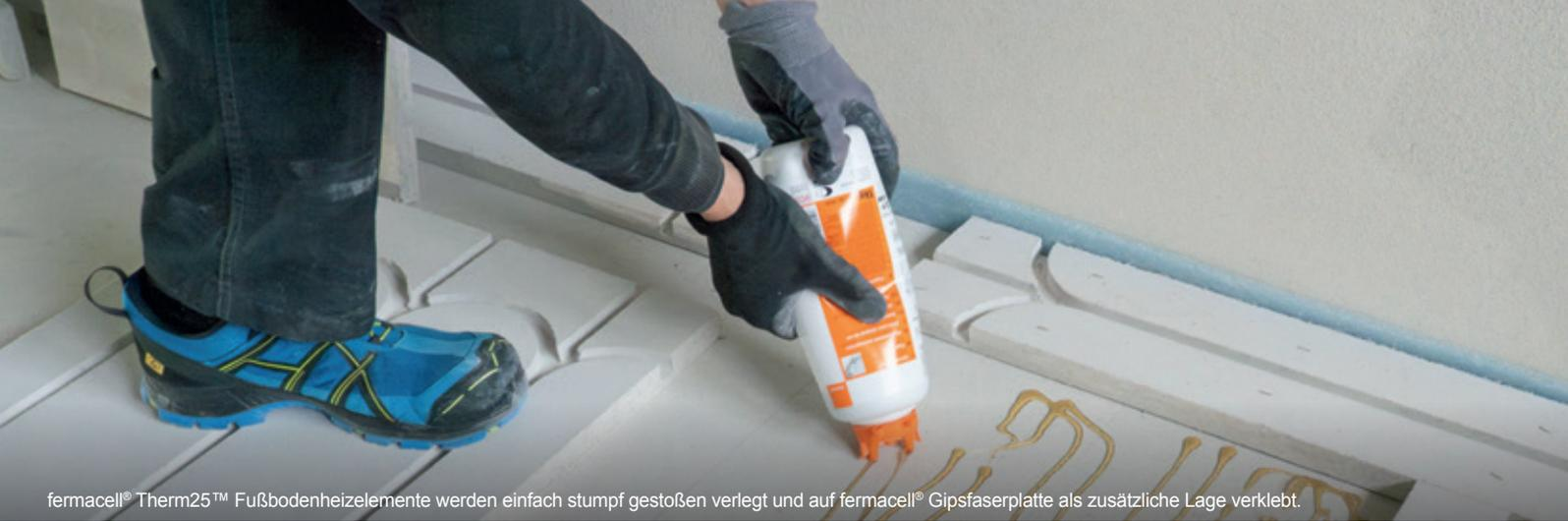
fermacell® Therm25™ Fußbodenheizelemente werden einfach stumpf gestoßen verlegt und auf fermacell® Gipsfaserplatte als zusätzliche Lage verklebt.
