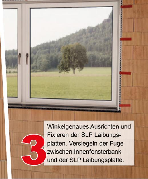
**3** Winkelgenaues Ausrichten und Fixieren der SLP Laibungsplatten. Versiegeln der Fuge zwischen Innenfensterbank und der SLP Laibungsplatte.
