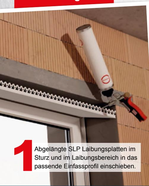
**1** Abgelängte SLP Laibungsplatten im Sturz und im Laibungsbereich in das passende Einfassprofil einschieben.
