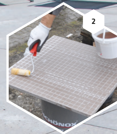
2 Kontaktschicht mit SCHÖNOX EP DRAIN pur auf die Fliesenrückseite aufröllen.
