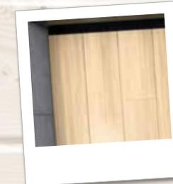
Eine weitere Möglichkeit für einen Deckenabschluss bietet eine sogenannte Schattenfuge. Hierfür werden die äußersten Traglatten der Unterkonstruktion durch meistens mattschwarz lackierte Glatkantbretter ersetzt. Wichtig dabei ist, dass die Paneele und Profile alle gerade in der gleichen Höhe enden, damit ein sauberer Abschluss entsteht. Dadurch entsteht ein schöner Schatteneffekt.
