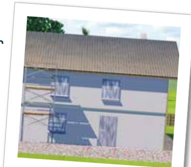
Decken Sie insbesondere bei Verwendung von silikathaltiger Fassadenfarbe unbedingt die Fenster mit einer geeigneten Schutzfolie ab! Silikat schadet dem Fenster und hinterlässt „blinde“ Flecken.
