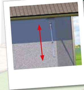
Für die Reihenfolge beim Streichen gilt: Streichen Sie zuerst alle Ecken und Kanten mit einem Flachpinsel. Danach streichen Sie zusammenhängende Flächen mit einer geeigneten Farbwalze.
