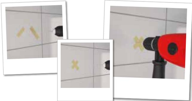
Falls Sie auf glatten Untergründen wie Fliesen bohren müssen und nicht in den Fugen bohren können, kann der Bohrer leicht verrutschen. Kleben Sie hier einfach etwas Krepp- oder Klebeband auf die Fliese, um ein Abrutschen zu vermeiden. Sanftes Drehbohren in Kombination mit dem Klebeband verhindert ein Absplittern der Fliesenglasur.
