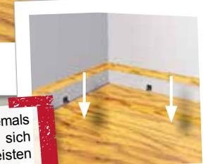
Noch einfacher und schneller geht das Verlegen mit Laminatböden im **Fold-Down-System** (H). Hier können Sie das Paneel direkt an der Längs- und Querseite ansetzen und ohne Werkzeuge einrasten lassen.
