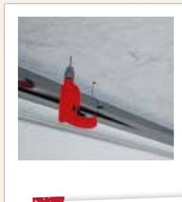
Bei Holzbalken, die etwas näher zusammenliegen, können Sie die Abhänger auch direkt an den Balken befestigen.
