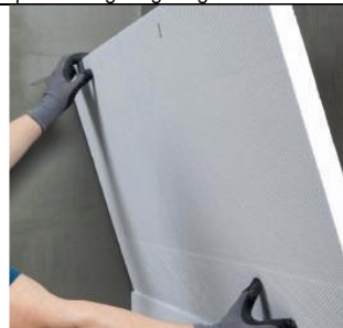
Prima Reaktivabdichtung 2K können auf den erhärteten Untergrund Drain- und Dämmplatten geklebt werden.
