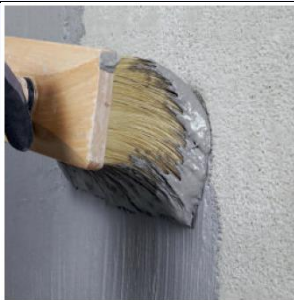
Aufbringen einer Kontaktschicht mittels Bürste oder Quast.
