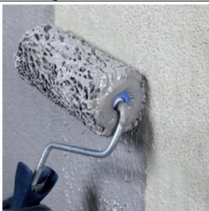
Aufbringen einer Kontaktschicht mit dem Roller.
