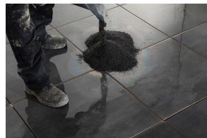
3. Prima Pflasterfugenmörtel portionsweise aufbringen
