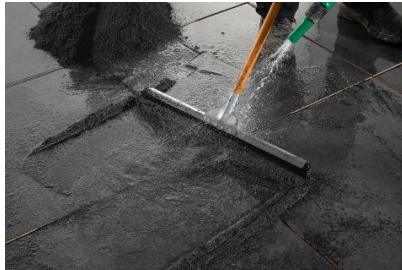
4. Prima Pflasterfugenmörtel mit Hartgummischieber und Wassersprühstrahl einarbeiten
