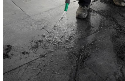
5. Oberfläche mit weichem Wassersprühstrahl reinigen
