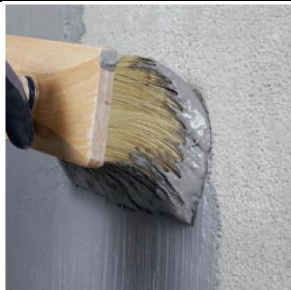
Aufbringen einer Kontaktschicht mittels Bürste oder Quast.
