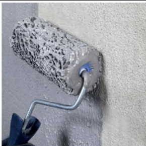
Aufbringen einer Kontaktschicht mit dem Roller.
