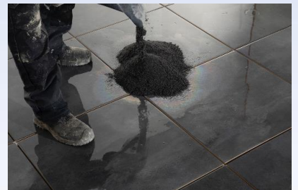
Prima Pflasterfugenmörtel portionsweise aufbringen
