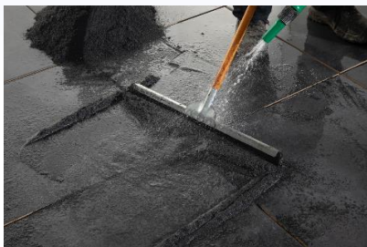
Prima Pflasterfugenmörtel mit Hartgummi-schieber und Wassersprühstrahl einarbeiten
