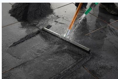
Prima Pflasterfugenmörtel mit Hartgummi- schieber und Wassersprühstrahl einarbeiten
